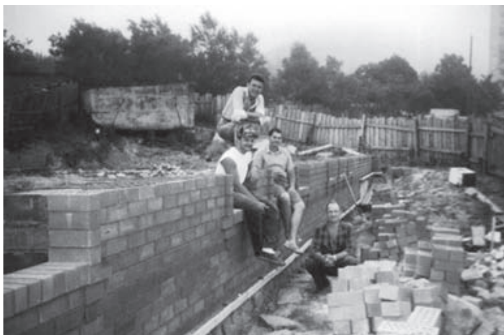
Строительство молитвенного дома, 1997
